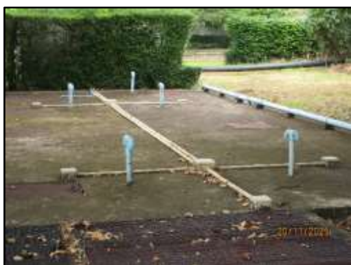
รูปที่ 5 ท่อระบายอากาศ ของระบบบำบัดน้ำเสีย
