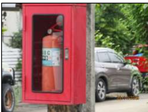
รูปที่ 32 (ต่อ) หัวจ่ายน้ำดับเพลิง และถังดับเพลิงเคมีแบบมือถือ
