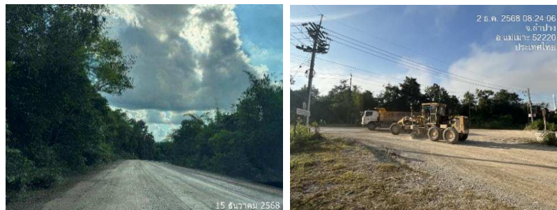
รูปที่ 3.7-1 การปรับปรุงสภาพทางขนส่งแร่ให้สามารถใช้งานได้ดี
