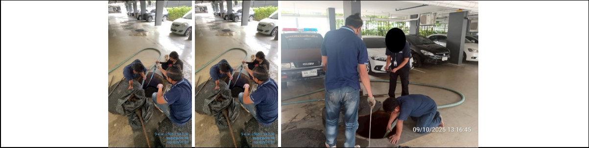
รูปที่ ผ7.15 สับตะกอนส่วนเกิน และไขมันออกจากระบบบำบัดน้ำเสีย
