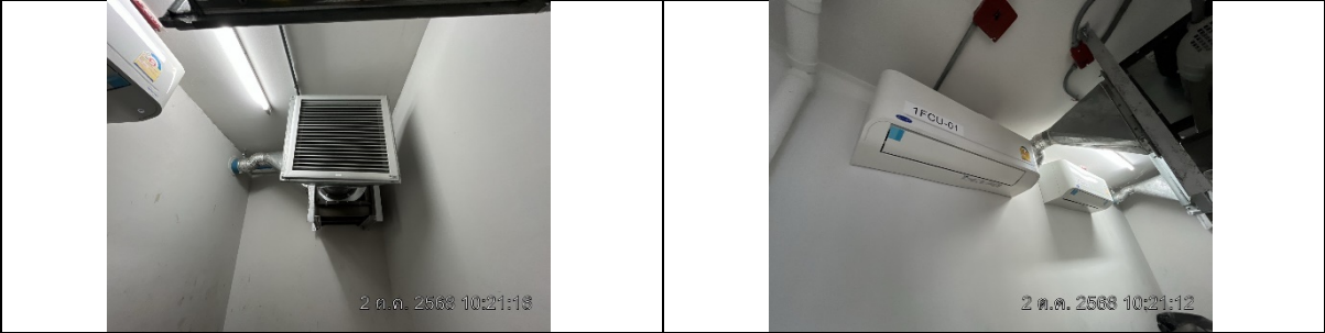
รูปที่ ผ7.7 พัดลมดูดอากาศจากห้องพักมูลฝอยเปียก
