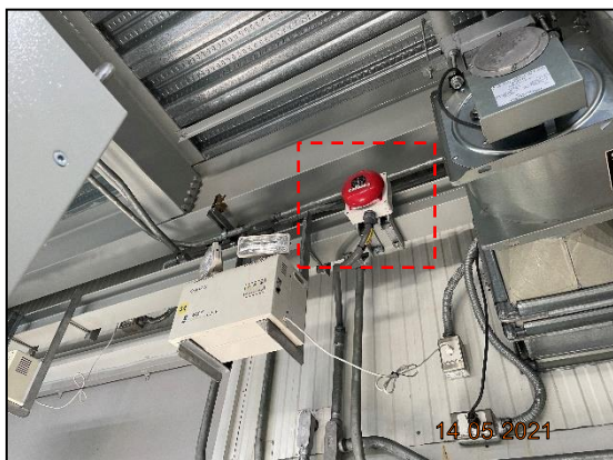
รูปที่ 2-20 สัญญาณเตือนไฟไหม้
