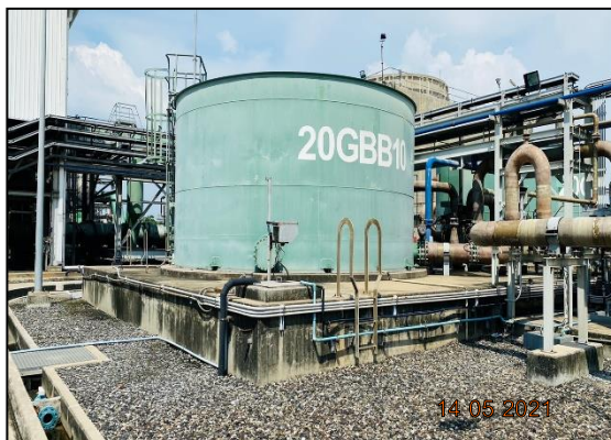
รูปที่ 2-9 บ่อรวบรวมน้ำทิ้งจากกระบวนการผลิต
