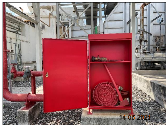
หัวฉีดน้ำดับเพลิง และตู้สายน้ำดับเพลิง
