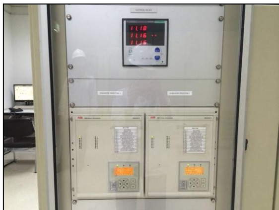
รูปที่ 2-30 ระบบป้องกันไฟฟ้า (Relay) ที่เครื่องกำเนิดไฟฟ้า และหม้อแปลงไฟฟ้า
