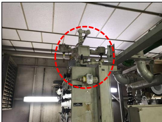
รูปที่ 2-17 อุปกรณ์ตรวจจับก๊าซรั่วไหล
