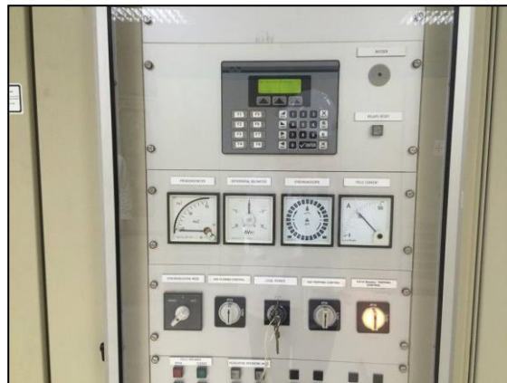
รูปที่ 2-30 ระบบป้องกันไฟฟ้า (Relay) ที่เครื่องกำเนิดไฟฟ้า และหม้อแปลงไฟฟ้า
