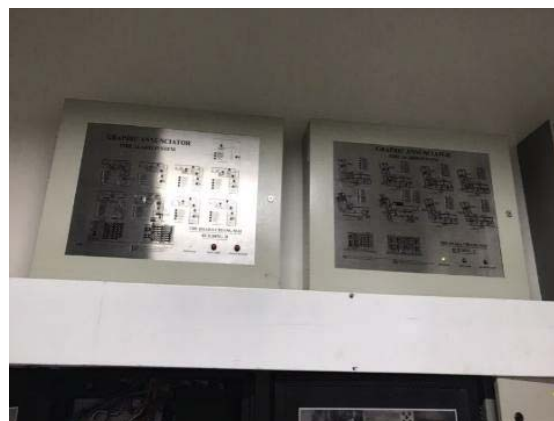
รูป2-29 อุปกรณ์แจ้งเหตุแบบส่งสัญญาณ
