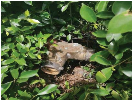
รูป2-33 ท่อขึ้นรับน้ำดับเพลิงจากภายนอกอาคาร
