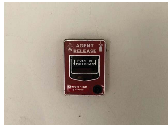
รูป2-28 อุปกรณ์แจ้งเหตุเพลิงไหม้แบบใช้มือ
