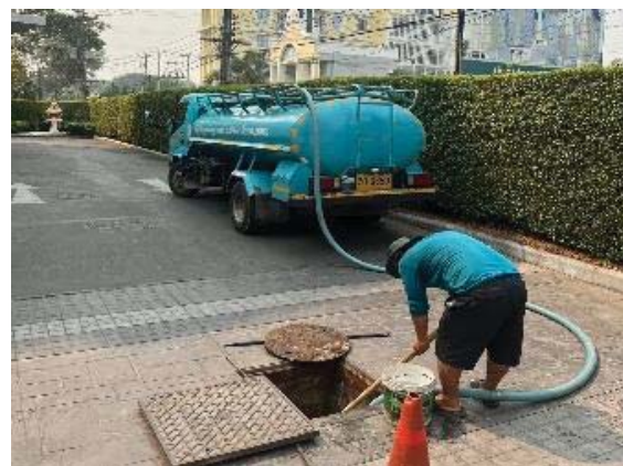
รูป2-22 สูบกากตะกอนระบบบำบัด
