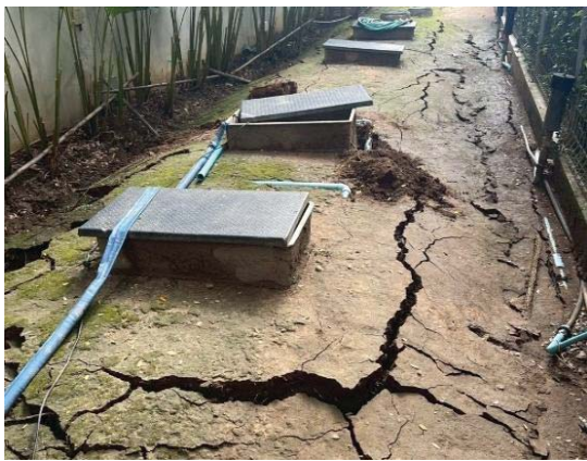
รูป2-9 ระบบบำบัดน้ำเสียหลังดินทรุด
