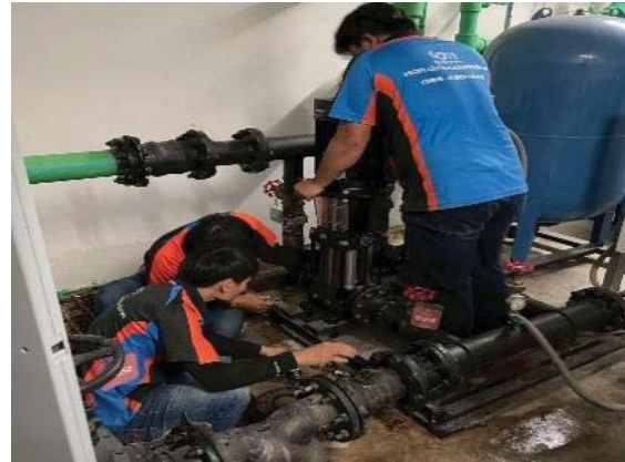
รูป2-20 ซ่อมบำรุงระบบสูบน้ำในอาคาร
