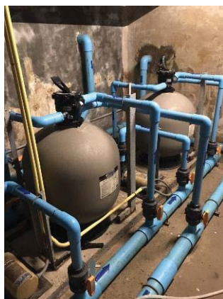
รูป2-51 ระบบบำบัดน้ำเสียน้ำสระว่ายน้ำ
