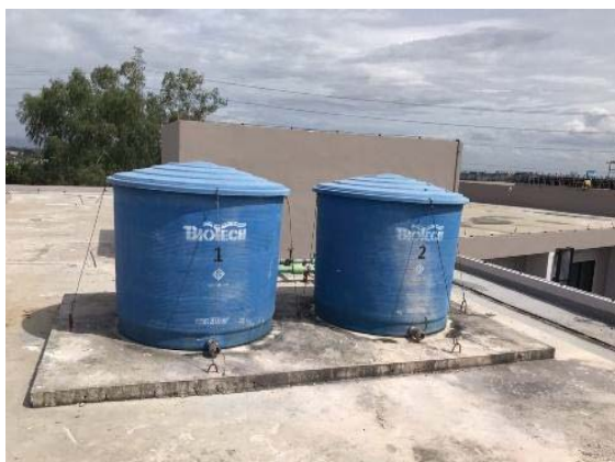
รูป2-17 ถังเก็บน้ำบนหลังคา
