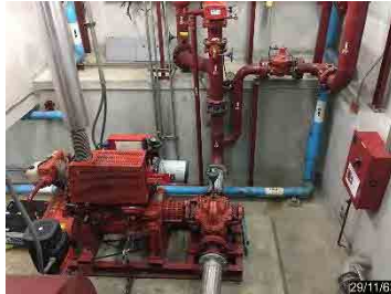
ภาพที่ 2-10 ระบบสูบน้ำในอาคาร
