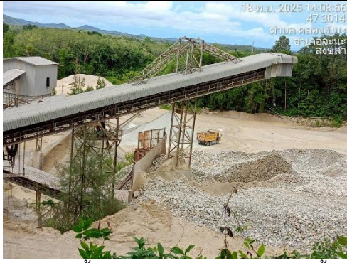
รูป 17 การติดตั้งอุปกรณ์ปิดคลุมโดยตลอดพร้อมทั้งติดตั้งเครื่องฉีดสเปรย์น้ำ
