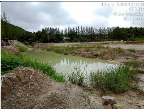
รูป 5 บ่อดักตะกอน
