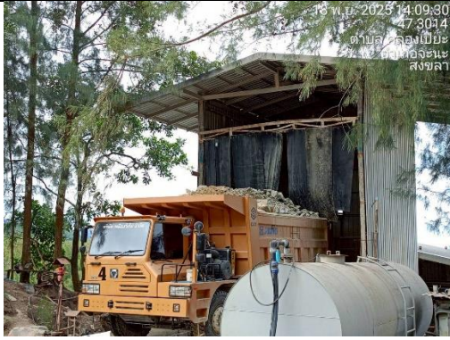
รูป 9 การปิดคลุมปากม่แรก
