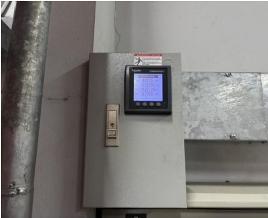
รูปที่ 2-13 ติดตั้งมาตรวัดไฟฟ้าในส่วนของระบบบำบัดน้ำเสีย แยกออกจากส่วนอื่นๆ
