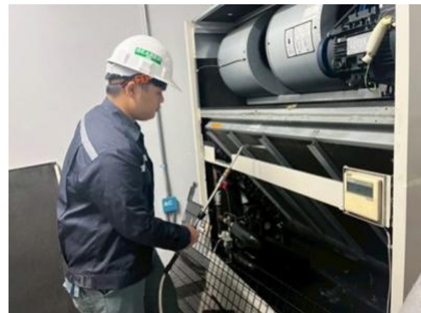
รูปที่ 2-50 ทำความสะอาดแผงกรองอากาศเครื่องส่งลมเย็น
