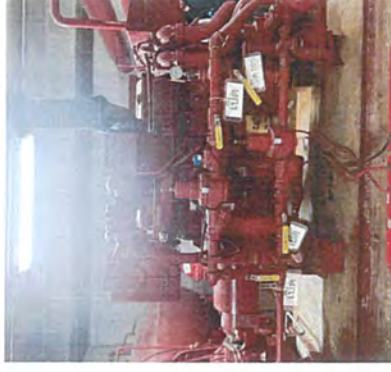
รูปที่ 1.1 เครื่องสูบน้ำดับเพลิง
