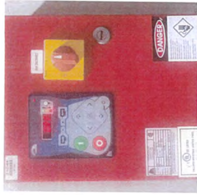
รูปที่ 1.3 ตู้ควบคุมน้ำส้วมแรงดัน
