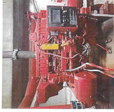
รูปที่ 3.1 เครื่องสูบน้ำดับเพลิง
