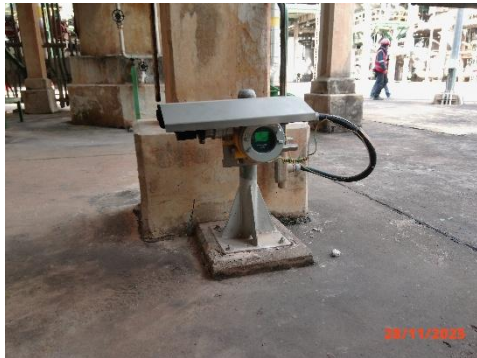
อุปกรณ์ตรวจจับก๊าซ (Gas Detector)
