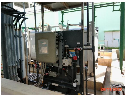
รูปที่ 2-5 การติดตั้ง ORP Analyzer ที่ระบบ Cooling Water System
