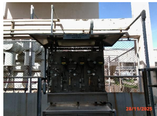
รูปที่ 2-5 การติดตั้ง ORP Analyzer ที่ระบบ Cooling Water System
