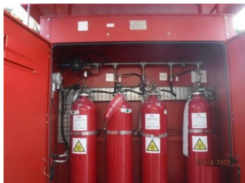
ระบบดับเพลิงแบบก๊าซคาร์บอนไดออกไซด์ (CO 2 Suppression System)
