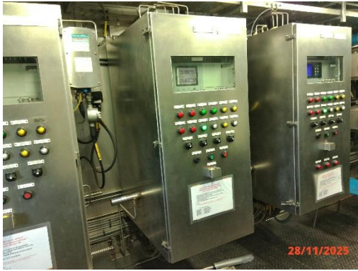
รูปที่ 2-1 ระบบ CEMs ที่ปล่อง H-100H
