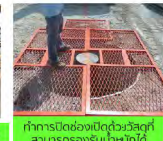
การปิดช่องเปิดด้วยวัสดุที่สามารถรองรับน้ำหนักได้มากกว่า 120 กิโลกรัม/ตารางเมตรอย่างแข็งแรงโดยการยึดอย่างมั่นคง
