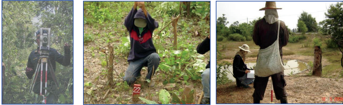
ขั้นตอนที่ 1 งานสำรวจแนวสายส่งและกำหนดตำแหน่งเสาไฟฟ้า
