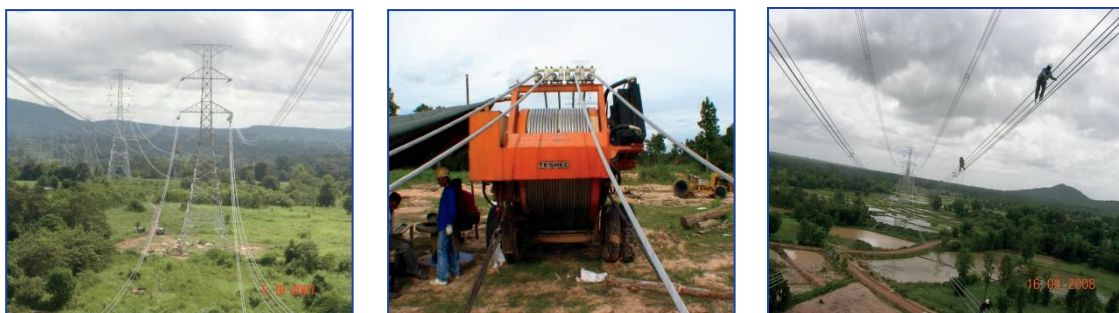
ขั้นตอนที่ 6 งานชิงสายไฟฟ้า และตรวจสอบสายส่งไฟฟ้าก่อนจ่ายไฟ
