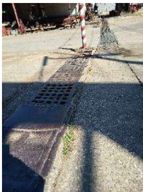
รูปที่ 21 รางระบายน้ำฝนภายในพื้นที่โครงการ
