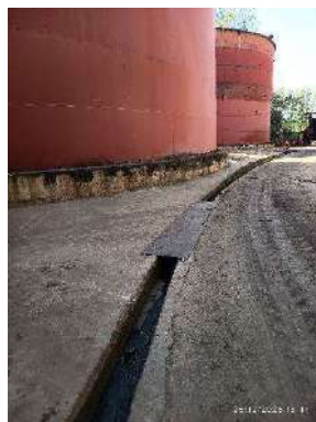
รูปที่ 21 รางระบายน้ำฝนภายในพื้นที่โครงการ
