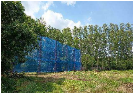
รูปที่ 3 การปลูกต้นไม้ทรงสูงและติดตั้งผ้าใบด้านเหนือลมป้องกันการฟุ้งกระจายของฝุ่น
