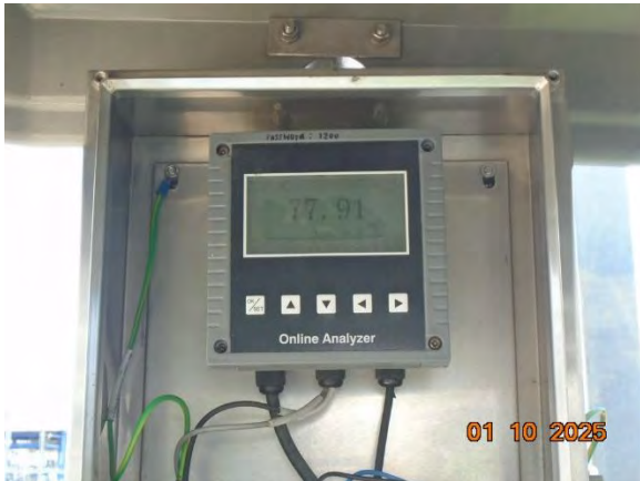
ภาพที่ 2.2-9 ระบบตรวจสอบคุณภาพน้ำแบบต่อเนื่อง Online Monitoring บริเวณบ่อพักน้ำหล่อเย็น
