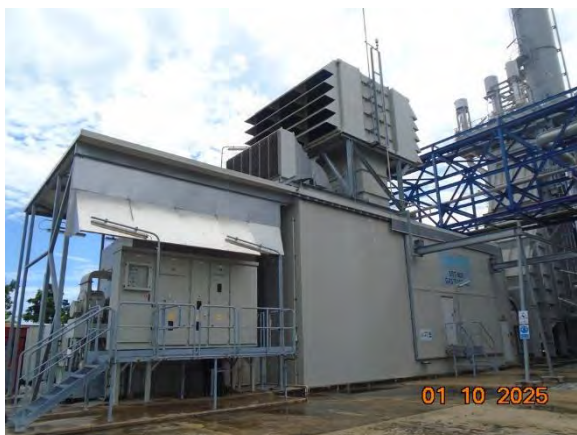
ภาพที่ 2.2-5 อาคารคลุมเครื่องจักร (Enclosure)
