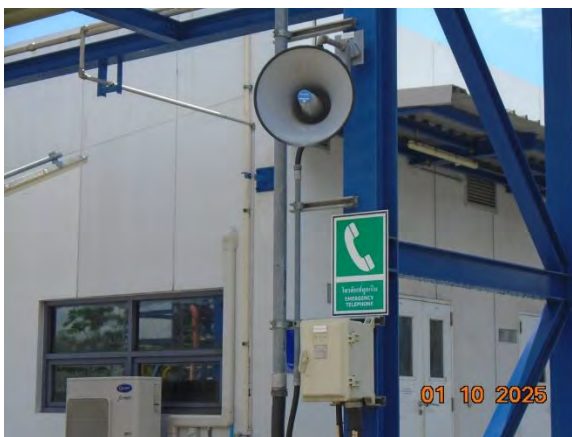
ภาพที่ 2.2-32 สัญญาณแจ้งเหตุเพลิงไหม้ (Fire Alarm)
