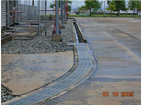
ภาพที่ 2.2-27 รางระบายน้ำในพื้นที่โครงการ
