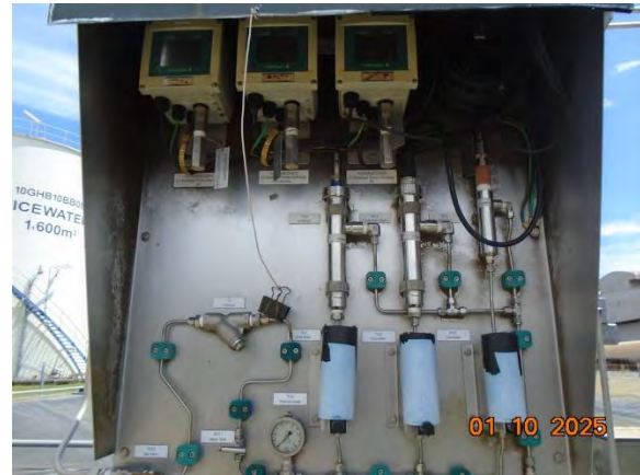
ภาพที่ 2.2-9 ระบบตรวจสอบคุณภาพน้ำแบบต่อเนื่อง Online Monitoring บริเวณบ่อพักน้ำหล่อเย็น
