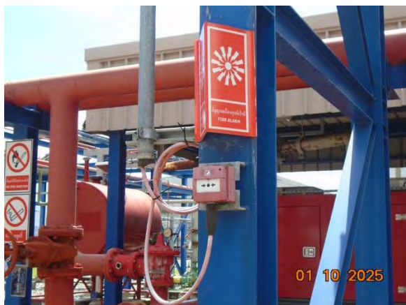
ภาพที่ 2.2-32 สัญญาณแจ้งเหตุเพลิงไหม้ (Fire Alarm)
