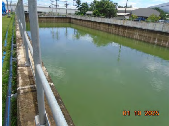
ภาพที่ 2.2-28 บ่อหน่วงน้ำฝนของโครงการ
