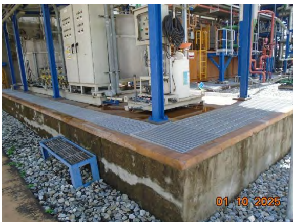
ภาพที่ 2.2-52 รางระบายบริเวณสถานที่เก็บสารเคมี
