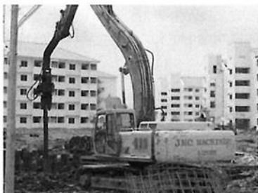
การปักแผ่นSheet Pile ด้วยรถแบคโฮติดหัวVibro
