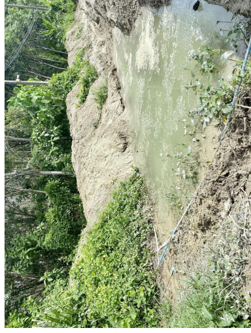
ภาพที่ 10 บ่อดักตะกอนดินเพื่อรองรับน้ำพุ่งขึ้นจากบริเวณ โรงไม้หิน
