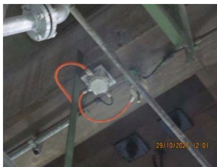
ภาพที่ 2-25 Heat Detector
