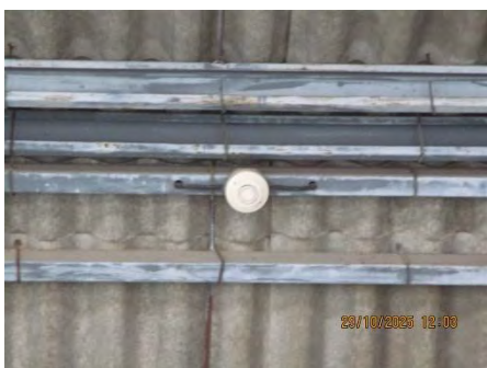
ภาพที่ 2-26 Smoke Detector
