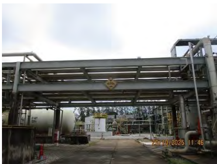
ภาพที่ 2-22 ท่อลำเลียงอยู่บนฐานรองรับเหนือพื้นพร้อมป้ายเตือนจำกัดความสูง
