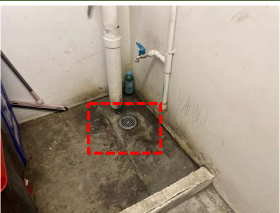
รูปที่ 2-57 ตะแกรงครอบรูท่อระบายน้ำ
