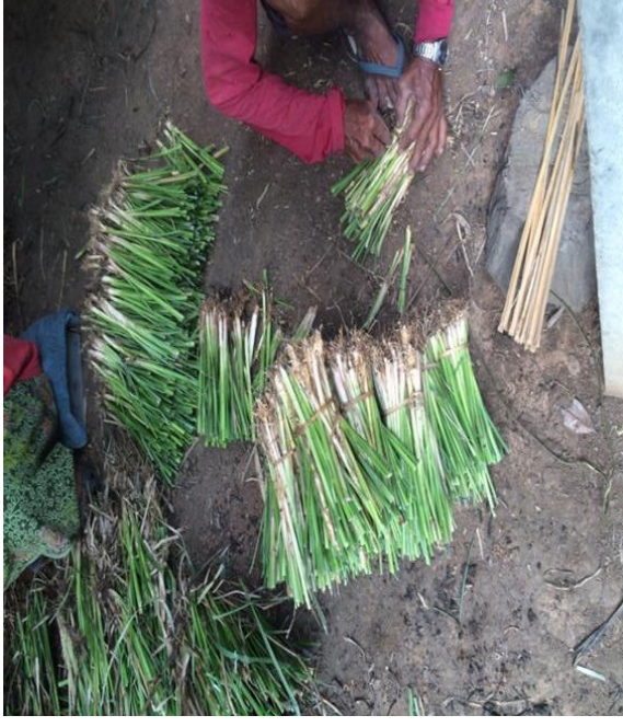
ภาพที่ แสดงการเตรียมพันธุ์ไม้หญ้าแฝก เพื่อปลูกแนวกันดินป้องกันดินสไลด์
