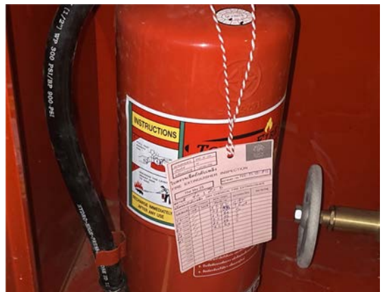
รูปที่ 2-83 ตรวจสอบถังดับเพลิง
