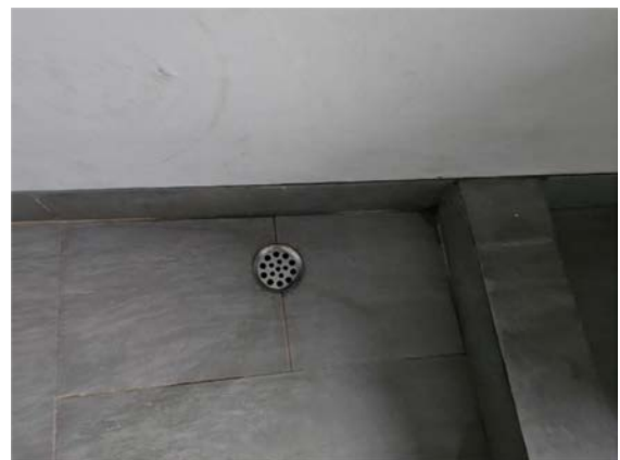
รูปที่ 2-28 ท่อระบายน้ำในห้องพักมูลฝอยรวม
