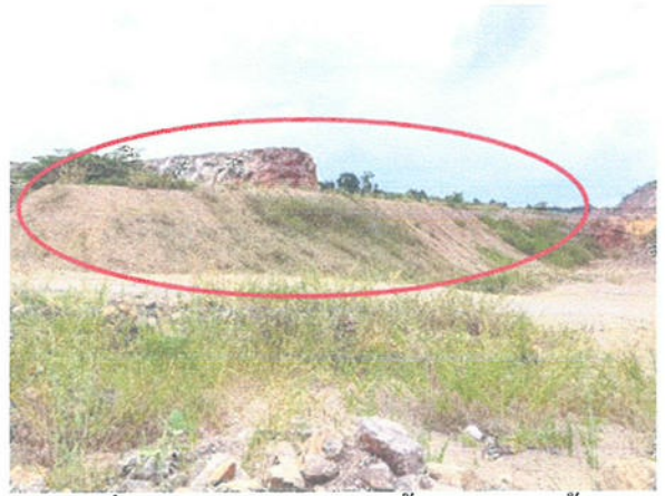
รูปที่ 4 นำเปลือกดินจากหน้าเหมืองมาสร้างคันทำนบดินและเตรียมปลูกไม้ยืนต้น
