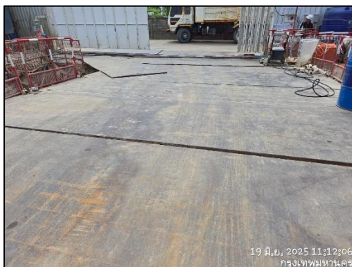
รูปที่ 48 แผ่นเหล็กปูรอง เพื่อลดความสั่นสะเทือนและระดับเสียง
