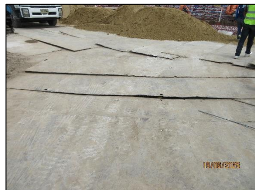
รูปที่ 48 แผ่นเหล็กปูรอง เพื่อลดความสั่นสะเทือนและระดับเสียง
