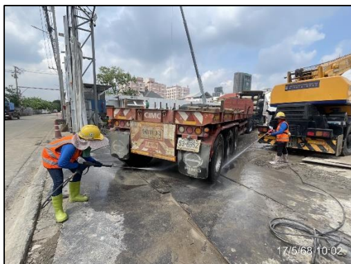
รูปที่ 23 พื้นที่จุดล้างล้อและการใช้สายฉีดน้ำแรงดันสูง (Water Jet) ล้างล้อรถบรรทุก
