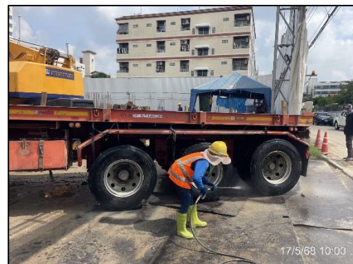
รูปที่ 23 พื้นที่จุดล้างล้อและการใช้สายฉีดน้ำแรงดันสูง (Water Jet) ล้างล้อรถบรรทุก
