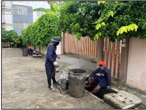
รูปที่ 60 การขุดลอกท่อระบายน้ำสาธารณะบนซอยถนนพลโยธิน
