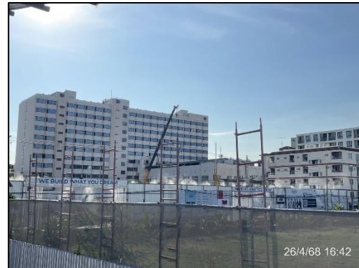
รูปที่ 31 ม่านละอองน้ำโดยรอบโครงการบริเวณรั้ว Metal Sheet ภายในด้านบนสุด
