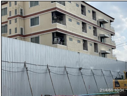
รูปที่ 31 ม่านละอองน้ำโดยรอบโครงการบริเวณรั้ว Metal Sheet ภายในด้านบนสุด
