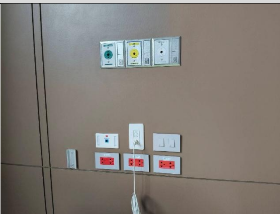
รูปที่ 2-17 การติดตั้ง เดินสายไฟฟ้า สื่อสารต่าง ๆ ที่เรียบร้อย
