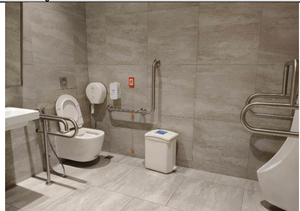
รูปที่ 2-9 สุขภัณฑ์แบบประหยัดน้ำ
