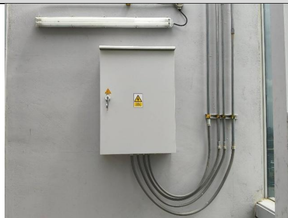
รูปที่ 2-17 การติดตั้ง เดินสายไฟฟ้า สื่อสารต่าง ๆ ที่เรียบร้อย
