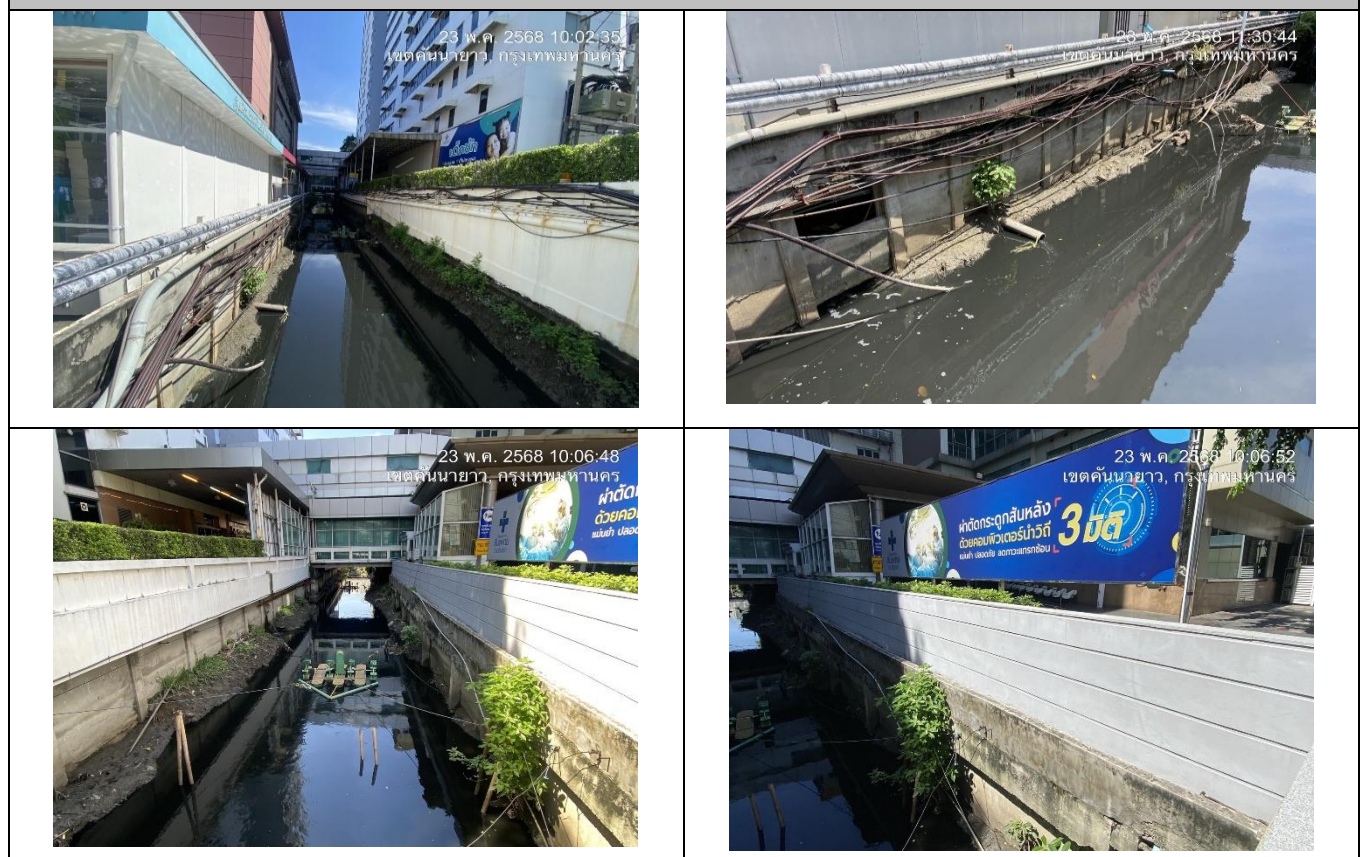
รูปที่ 2-2 แนวเขื่อนกันดินที่อยู่ในสภาพดี
