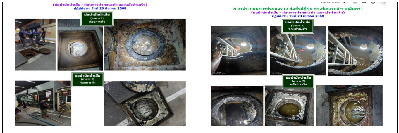
รูปที่ 2-9 การสูบล้างส่วนเกินออกจากถังแยกตะกอนของระบบบำบัดน้ำเสีย
