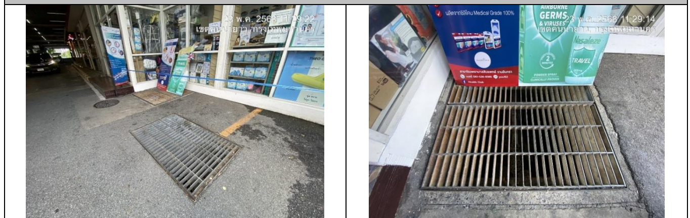
รูปที่ 2-10 ตำแหน่งทางเชื่อมระหว่างท่อระบบน้ำทิ้งที่ผ่านระบบบำบัดกับท่อระบายน้ำสาธารณะ
