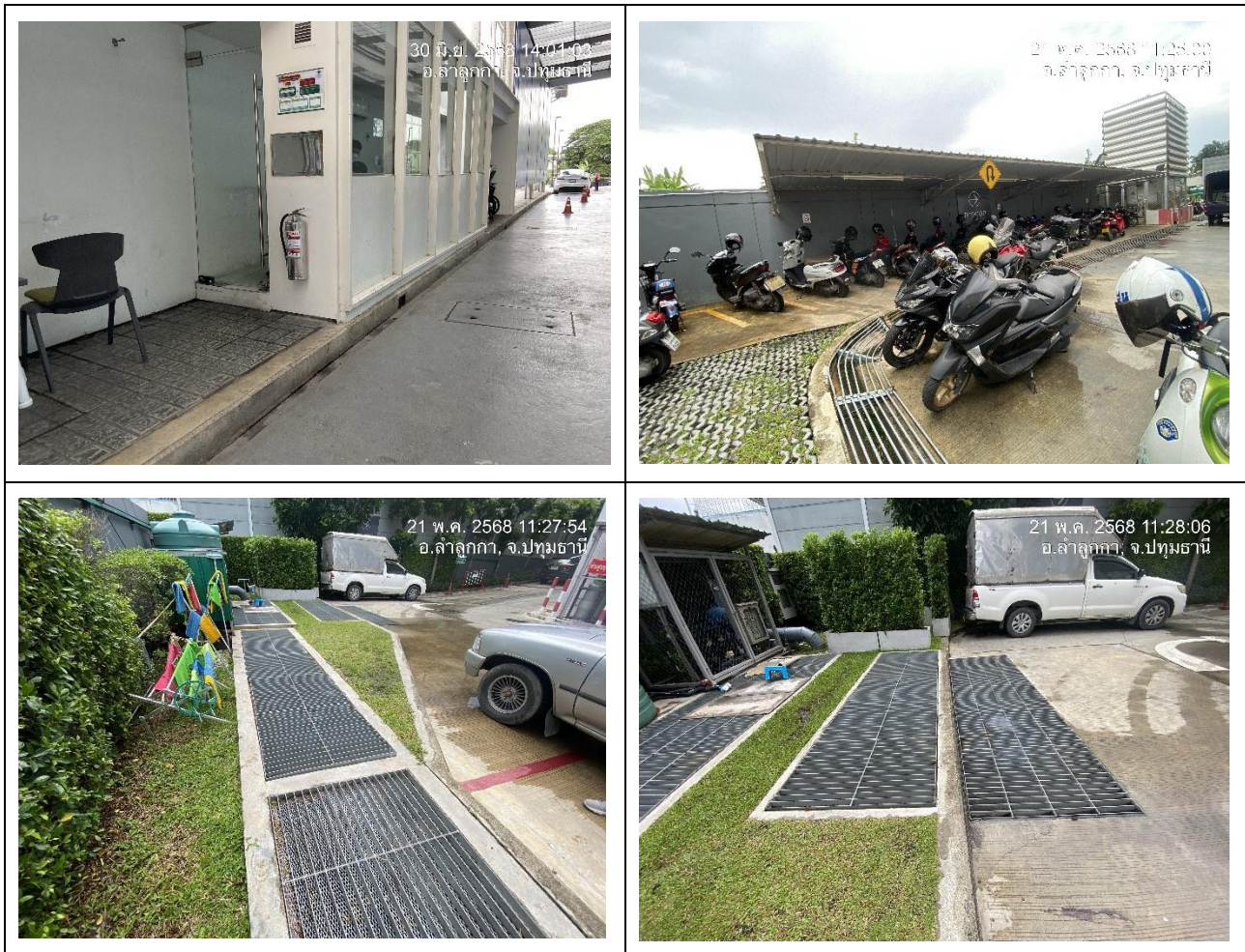
รูปที่ 3-15 การดูแลตรวจสอบท่อระบายน้ำไม่ให้มีขยะ ตะกอนอุดตัน
