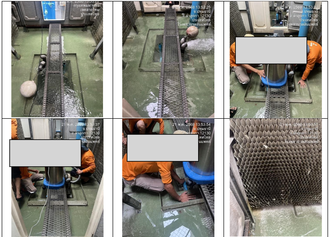
รูปที่ 2-45 การตรวจสอบและการทำความสะอาดห่อฝังเย็น
