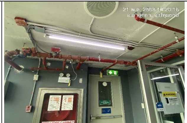
รูปที่ 2-31 อุปกรณ์เดินสายไฟฟ้า และอุปกรณ์ไฟฟ้าที่ถูกต้องตามมาตรฐาน
