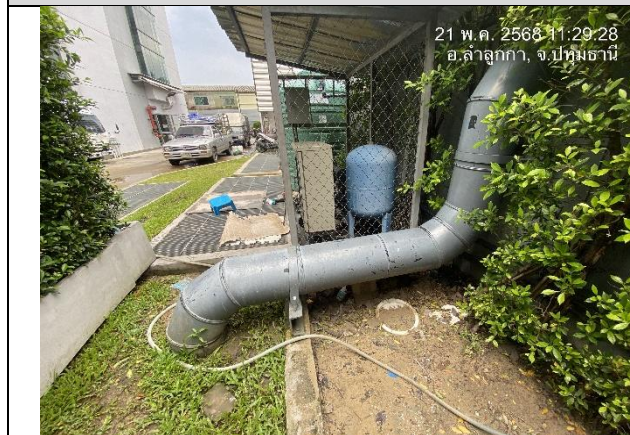
รูปที่ 2-18 เครื่องสูบน้ำเพื่อระบายน้ำฝน
