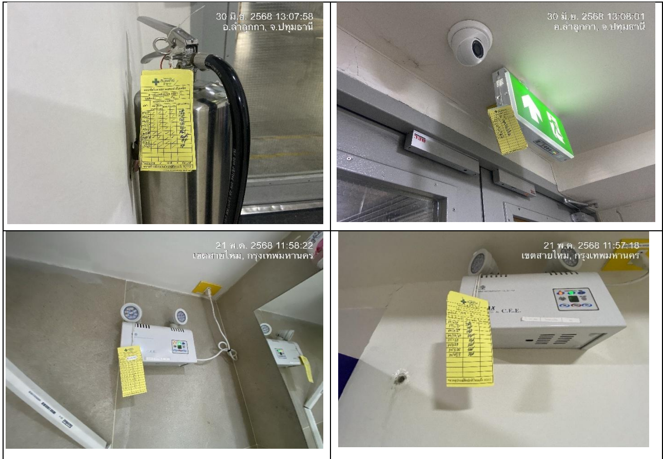
รูปที่ 3-19 การตรวจสอบอุปกรณ์ระบบป้องกันอัคคีภัย
