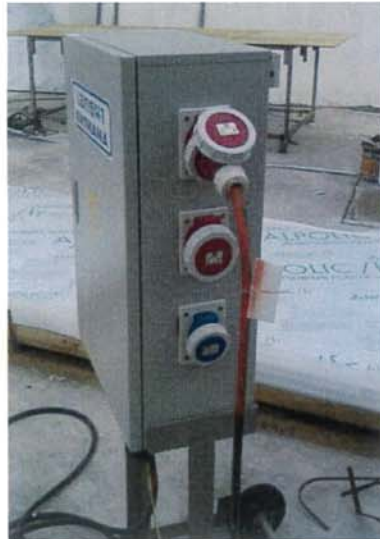
ภาพตัวอย่าง แผงไฟฟ้าชั่วคราว ในโครงการและการตรวจสอบ
