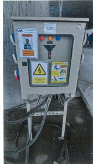
ภาพตัวอย่าง แผงไฟฟ้าชั่วคราว ในโครงการและการตรวจสอบ
