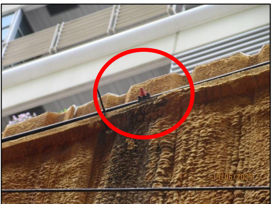
รูปที่ 15 ติดตั้งระบบฟ้นละอองสเปรย์น้ำ บริเวณรั้ว Metal Sheet รอบโครงการ
