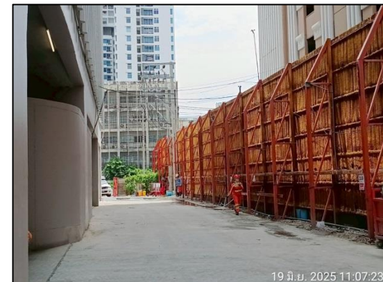
รูปที่ 4 รั้ว Metal Sheet ความหนา 1.27 มิลลิเมตร (หรือวัสดุที่เทียบเท่าหรือดีกว่า) ความสูง 6 เมตร โดยรอบบริเวณ โครงการ
