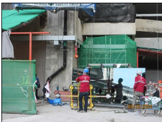
รูปที่ 45 การขนย้ายวัสดุขนาดใหญ่อย่างระมัดระวังเพื่อความปลอดภัยจากการตกหล่นและไม่ก่อให้เกิดเสียง
