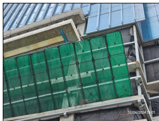
รูปที่ 51 Chain Link ขึ้นจากอาคารขณะทำโครงสร้าง
