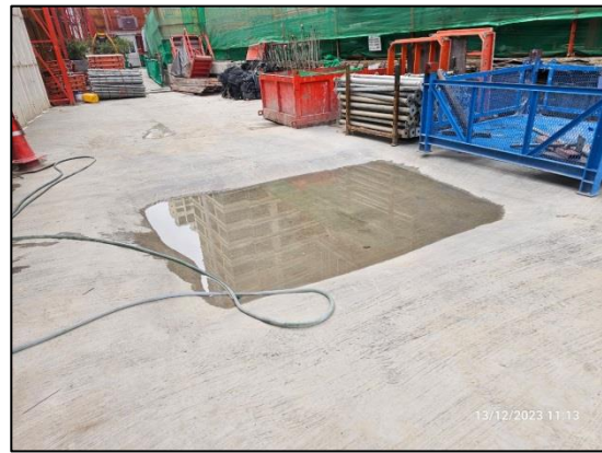
รูปที่ 11 พื้นที่ทำความสะอาดล้อบรรทุก และเจ้าหน้าที่ใช้น้ำฉีดล้างล้อก่อนออกจากโครงการ
