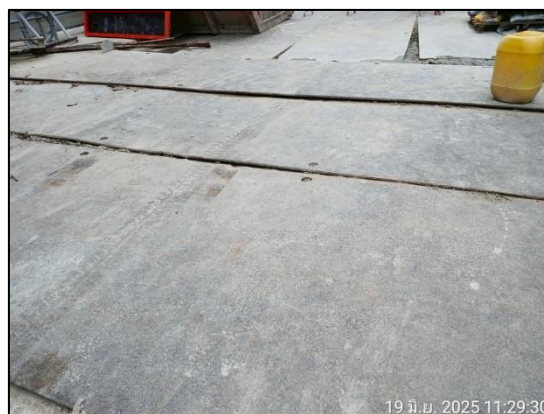
รูปที่ 21 ปูแผ่นเหล็ก (Platform) เพื่อลดความสั่นสะเทือนจากการเดินรถด้านหน้า และภายในพื้นที่โครงการ
