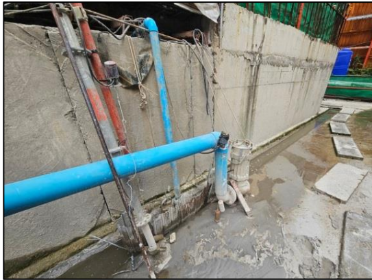
รูปที่ 27 เครื่องสูบน้ำ เพื่อสูบน้ำจากก่อสร้างเข้าสู่บ่อพักน้ำ ที่อยู่โดยรอบพื้นที่โครงการ
