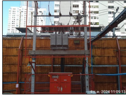
รูปที่ 34 หม้อแปลงไฟฟ้าในพื้นที่ก่อสร้าง เพื่อควบคุมปริมาณการใช้ไฟฟ้า
