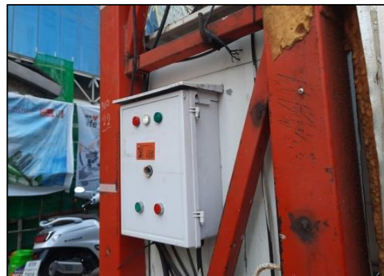
รูปที่ 42 ติดตั้งเครื่องแจ้งเหตุเตือนเพลิงไหม้ ด้วยเสียง Alarm Bell
