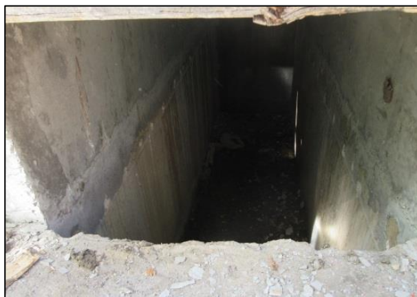
รูปที่ 26 รางระบายน้ำ บริเวณโดยรอบของพื้นที่โครงการ เพื่อรวบรวมน้ำเข้าสู่บ่อพักน้ำ
