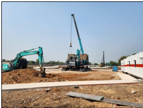
รูปที่ 36 การตอกเสาเข็ม และใช้ผ้ากระสอบหุ้มหัวเสาเข็ม
