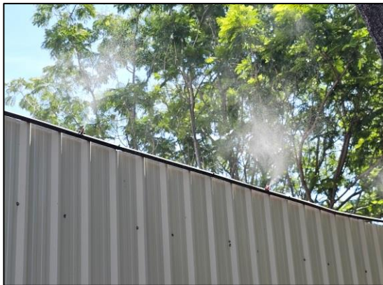
รูปที่ 30 ติดตั้งระบบพ่นละอองสเปรย์น้ำ บริเวณรั้ว Metal Sheet รอบโครงการ
