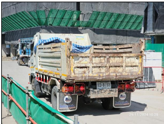
รูปที่ 24 ปิดคลุมกระเบบรบรรทุกของรถบรรทุกดิน หรือวัสดุอุปกรณ์ก่อสร้าง
