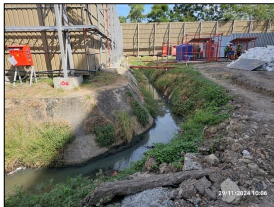
รูปที่ 37 ร่องน้ำ คสล. ความกว้างประมาณ 3 เมตร บริเวณรอบแนวเขตที่ดินด้านทิศเหนือ
