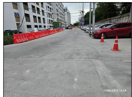
รูปที่ 33 จัดทำถนนคอนกรีต บริเวณภายในพื้นที่โครงการ
