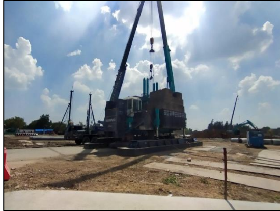
รูปที่ 36 การตอกเสาเข็ม และใช้ผ้ากระสอบหุ้มหัวเสาเข็ม
