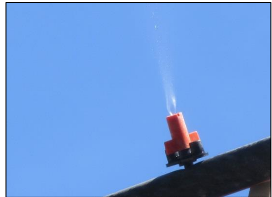
รูปที่ 30 ติดตั้งระบบพ่นละอองสเปรย์น้ำ บริเวณรั้ว Metal Sheet รอบโครงการ
