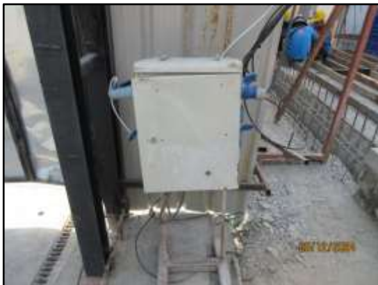
รูปที่ 24 ติดระบบมิเตอร์ไฟฟ้า เดินสายไฟฟ้าและระบบไฟฟ้าในพื้นที่ก่อสร้าง
