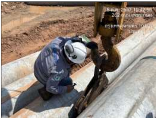
รูปที่ 16 เลือกใช้เสาเข็มกด ในการก่อสร้าง
