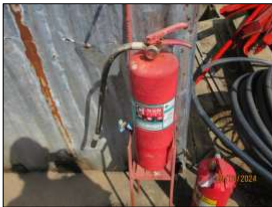
รูปที่ 26 ติดตั้งถังดับเพลิงชนิดมือถือไว้ภายในสำนักงานก่อสร้าง และพื้นที่เก็บวัสดุ
