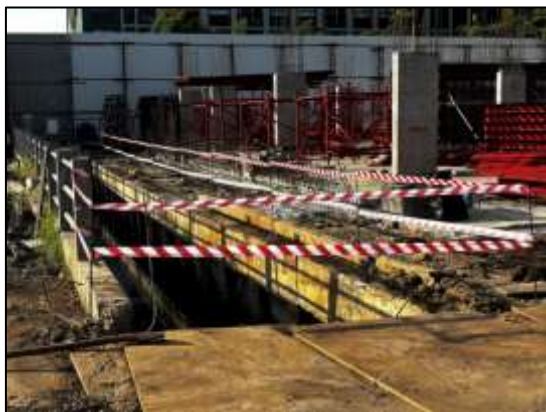
รูปที่ 18 ติดตั้งสิ่งกันตกหรือราวกัน
