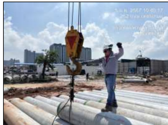
รูปที่ 16 เลือกใช้เสาเข็มกด ในการก่อสร้าง
