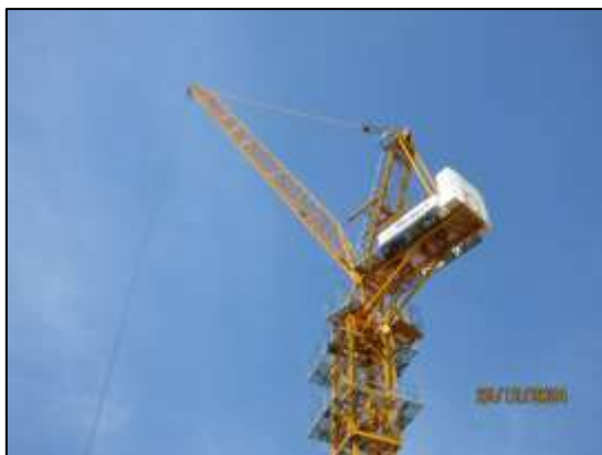
รูปที่ 29 ใช้เครนเป็นแบบพับแขนได้ และแขนของเครนจะต้องอยู่เฉพาะภายในพื้นที่โครงการเท่านั้น
