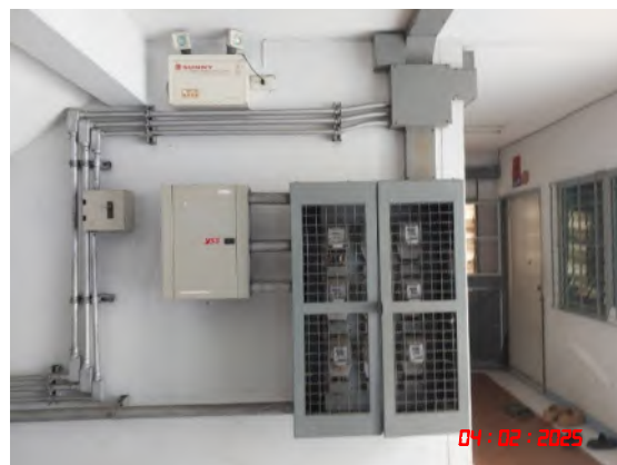
รูปที่ 10 มิเตอร์ไฟฟ้า
