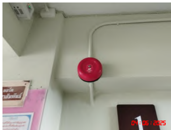
ระบบแจ้งเหตุเตือนภัยแบบกริ่ง
