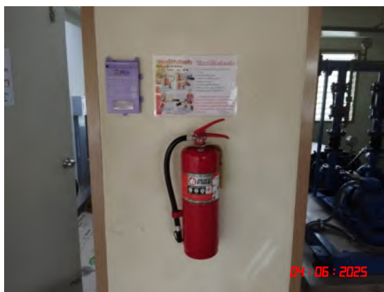
ถังดับเพลิงเคมีชนิดมือถือพร้อมวิธีการใช้ถังดับเพลิง
