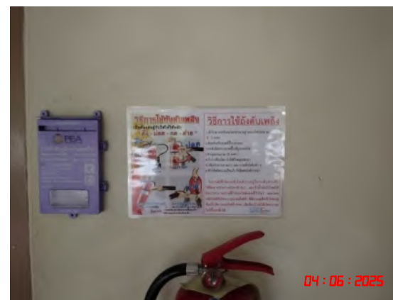
ถังดับเพลิงเคมีชนิดมือถือพร้อมวิธีการใช้ถังดับเพลิง
