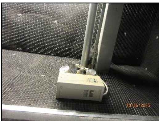
รูปที่ 71 ไฟฉุกเฉินอัตโนมัติ
