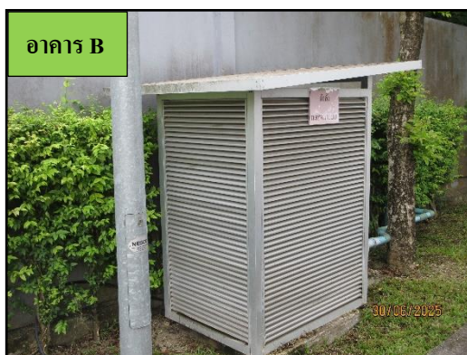
รูปที่ 20 เครื่องสำหรับเป่าเติมอากาศสำหรับระบบบำบัดน้ำเสีย
