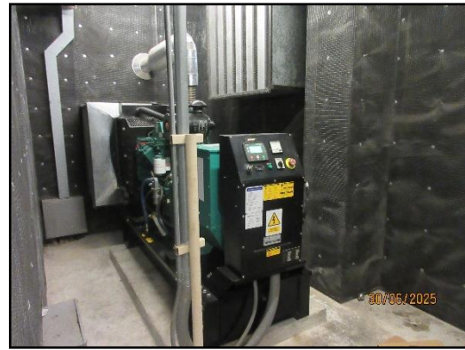
รูปที่ 16 (ต่อ) ฉนวนกันเสียง ช่องระบายอากาศ และท่อกำจัดไอดี
