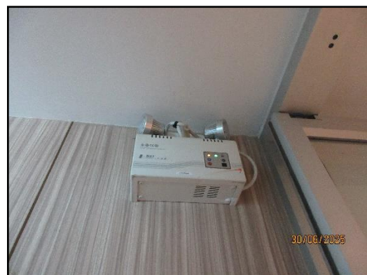
รูปที่ 71 ไฟฉุกเฉินอัตโนมัติ
