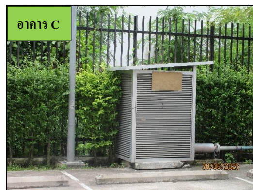
รูปที่ 20 เครื่องสำหรับเป่าเติมอากาศสำหรับระบบบำบัดน้ำเสีย
