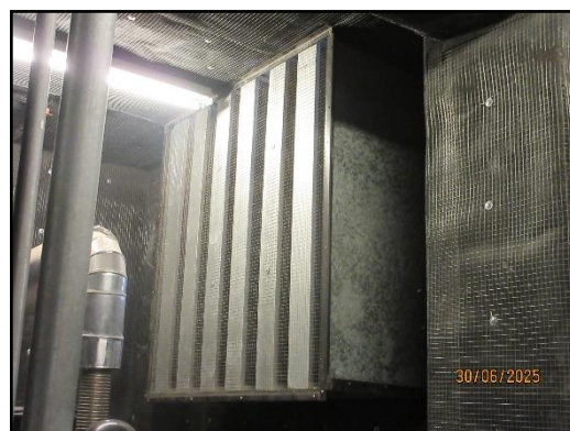
รูปที่ 16 ฉนวนกันเสียง ช่องระบายอากาศ และท่อกำจัดไอเสีย
