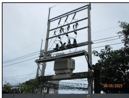
รูปที่ 48 หม้อแปลงไฟฟ้าเฉพาะของโครงการ
