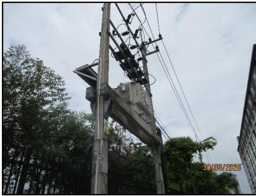
รูปที่ 48 (ต่อ) หม้อแปลงไฟฟ้าเฉพาะของโครงการ
