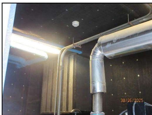
รูปที่ 16 ฉนวนกันเสียง ช่องระบายอากาศ และท่อกำจัดไอเสีย
