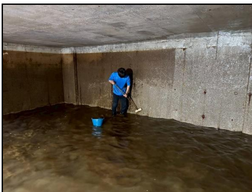
รูปที่ 44 การล้างทำความสะอาดถังเก็บน้ำสำรองของโครงการ
