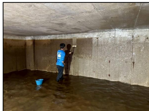
รูปที่ 44 การล้างทำความสะอาดถังเก็บน้ำสำรองของโครงการ
