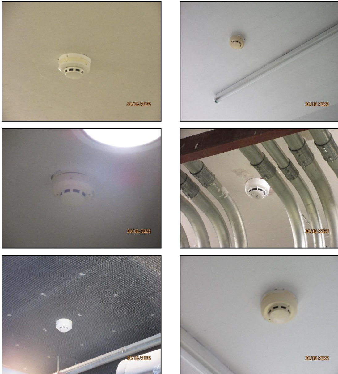
รูปที่ 68 อุปกรณ์ตรวจจับควัน
