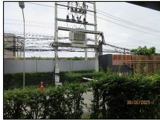
รูปที่ 48 (ต่อ) หม้อแปลงไฟฟ้าเฉพาะของโครงการ
