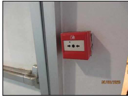
รูปที่ 70 (ต่อ) เครื่องแจ้งเหตุโดยใช้มือดึง และกริ่งสัญญาณเตือนภัย
