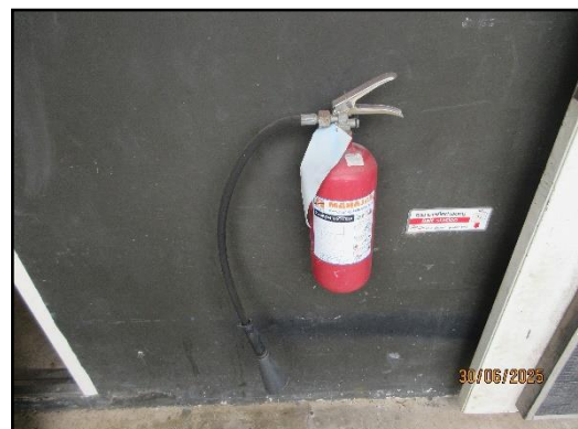
รูปที่ 72 ตู้เก็บสายฉีดน้ำดับเพลิงพร้อมอุปกรณ์ ถังดับเพลิงแบบมือถือพร้อมป้ายแนะนำการใช้ อุปกรณ์
