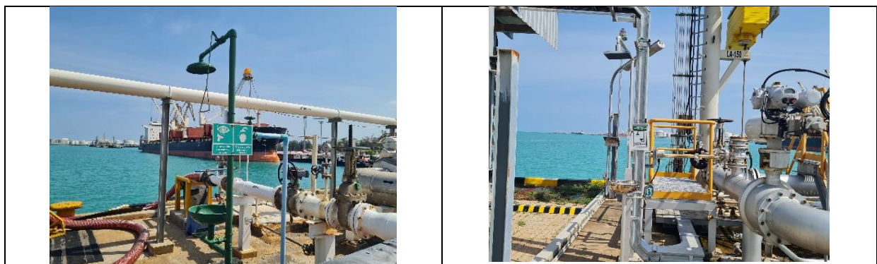
รูปที่ 2-37 ฝักบัวล้างตัว และล้างตาอย่างเต็มตัวบริเวณหน้าท่า
