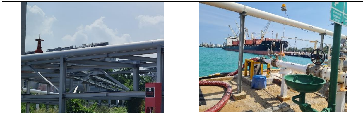
รูปที่ 2-38 ระบบหยุดการขนถ่ายแบบ Manual System (Block Value)
