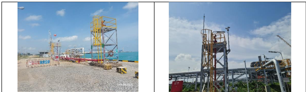
รูปที่ 2-40 หัวฉีดน้ำดับเพลิงบริเวณหน้าท่า (Fix Monitor)
