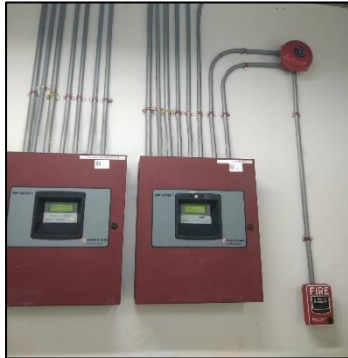
ก. เครื่องแจ้งเหตุโดยใช้น้ำมือคิง และ Alarm Bell
