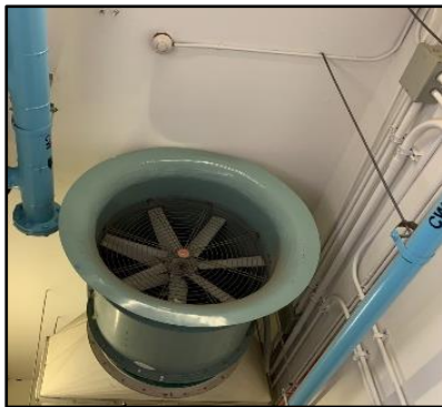
ฐ . พัฒมอัดอากาศ สำหรับบันไดหนีไฟ และลิฟต์ดับเพลิง
