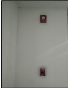
ก. เครื่องแจ้งเหตุโดยใช้น้ำมือคิง และ Alarm Bell
