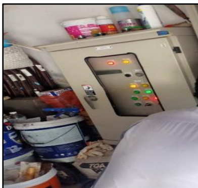
ภาพที่ 2-8 ตู้ควบคุมระบบน้ำเสียที่ผ่านการบำบัดแล้วไปรดน้ำต้นไม้
