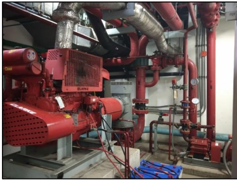
จ . ระบบ Fire Pump และ Jockey Pump
