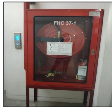
ข. ตู้เก็บสายฉีดน้ำดับเพลิงพร้อมอุปกรณ์
