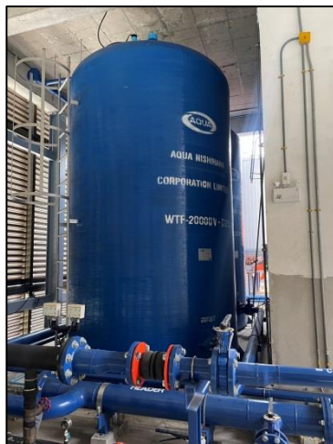
รูปที่ 14 ถังเก็บน้ำสำรอง
