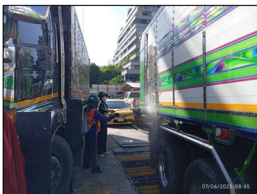
รูปที่ 11 คนงานทำความสะอาดล้อรถบรรทุกก่อนออกสู่ถนน
