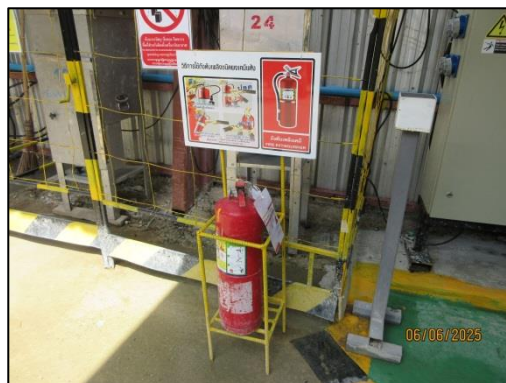
รูปที่ 43 ถังดับเพลิงชนิดมือถือภายใน โครงการ
