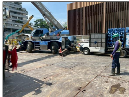
รูปที่ 27 การปูแผ่นเหล็ก (Platform)
