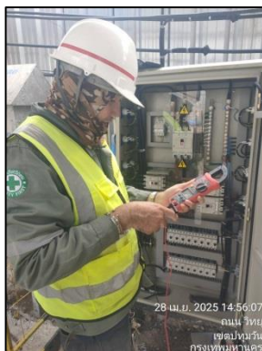
รูปที่ 48 เจ้าหน้าที่ตรวจสอบตู้จ่ายไฟฟ้า
