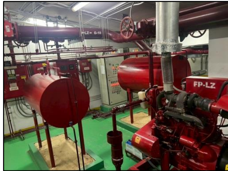
รูปที่ 27 ระบบท่อขึ้น ใช้ท่อขึ้นที่มีขนาดเส้นผ่านศูนย์กลาง 6 นิ้ว สำหรับพื้นที่ Low Zone และ High Zone
