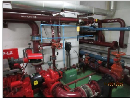
รูปที่ 27 ระบบท่อขึ้น ใช้ท่อขึ้นที่มีขนาดเส้นผ่านศูนย์กลาง 6 นิ้ว สำหรับพื้นที่ Low Zone และ High Zone
