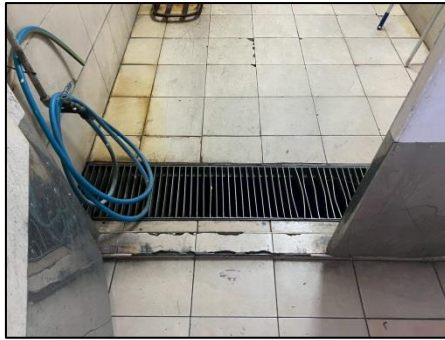
รูปที่ 21 รางระบายน้ำรวบรวมน้ำจากการล้างห้องพักมูลฝอยเข้าสู่ระบบบำบัดน้ำเสีย
