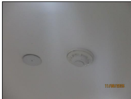
รูปที่ 36 Heat Detector ภายในอาคารชุดคิวหลังสวน
