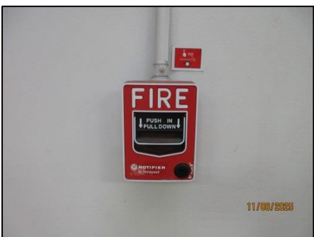
รูปที่ 37 Fire Alarm Bell และ Fire Alarm Manual Station ภายในอาคารชุดกึ่งหลังสวน
