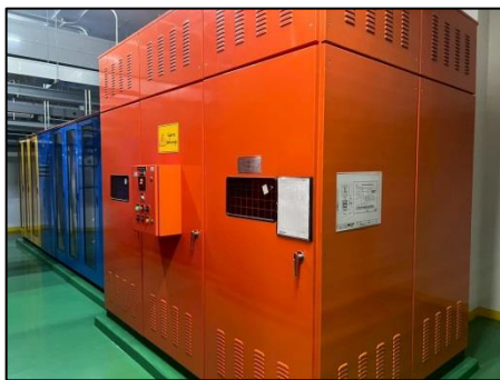
รูปที่ 22 ระบบไฟฟ้า Transformer ชนิด Dry Type Cast Resin ขนาด 2,000 KVA จำนวน 2 ชุด
