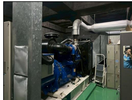
รูปที่ 23 เครื่องกำเนิดไฟฟ้าฉุกเฉิน (Generator) ขนาด 500 KVA จำนวน 1 เครื่อง
