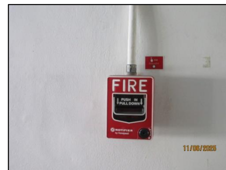
รูปที่ 37 Fire Alarm Bell และ Fire Alarm Manual Station ภายในอาคารชุดกึ่งหลังสวน
