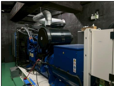
รูปที่ 23 เครื่องกำเนิดไฟฟ้าฉุกเฉิน (Generator) ขนาด 500 KVA จำนวน 1 เครื่อง
