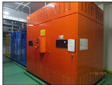
รูปที่ 22 ระบบไฟฟ้า Transformer ชนิด Dry Type Cast Resin ขนาด 2,000 KVA จำนวน 2 ชุด
