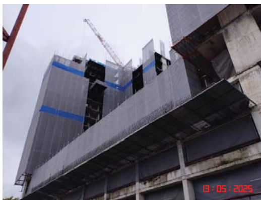
รูปที่ 6 การติดตั้ง Mesh Sheet และ Chain Link
