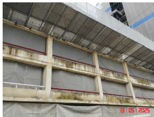
รูปที่ 6 การติดตั้ง Mesh Sheet และ Chain Link
