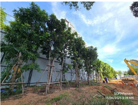
รูปที่ 19 การกันพื้นที่สำหรับต้นไม้เดิม
