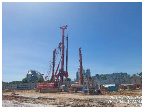
รูปที่ 16 เสาค้ำเสา (ผ่านช่วงเสาเข็มแล้ว)
