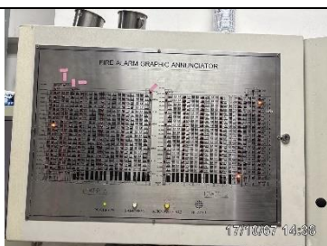
รูปที่ ฌ7.28 แผงควบคุมสัญญาณแจ้งเหตุเพลิง (FCB)
