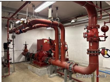
รูปที่ ผ7.40 เครื่องสูบน้ำดับเพลิง
