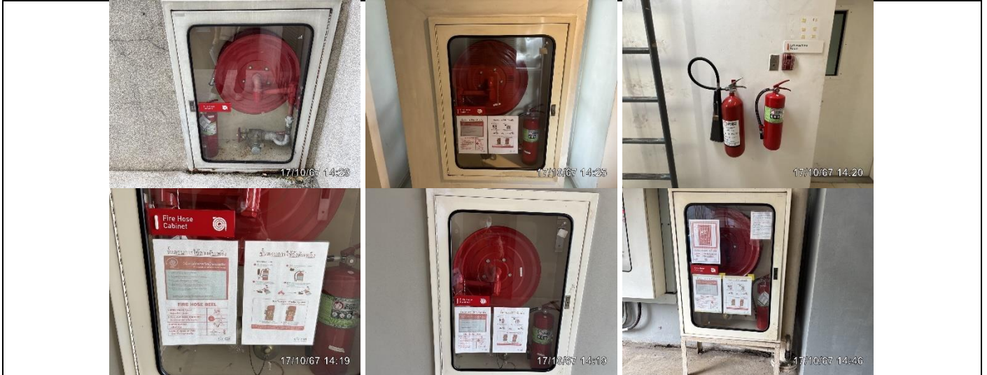
รูปที่ ๗.37 ตู้สายฉีดน้ำดับเพลิง ถังดับเพลิง และป้ายแนะนำวิธีการใช้
