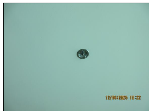
รูปที่ 51 หัวกระจายน้ำดับเพลิง (Sprinkler Head)
