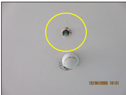
รูปที่ 50 (ต่อ) หัวจ่ายน้ำดับเพลิง
