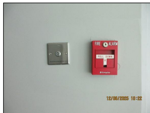
รูปที่ 56 ชุดกดแจ้งเหตุ (Manual Station)
