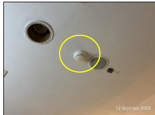
รูปที่ 58 เครื่องตรวจจับควัน (Smoke Detector)
