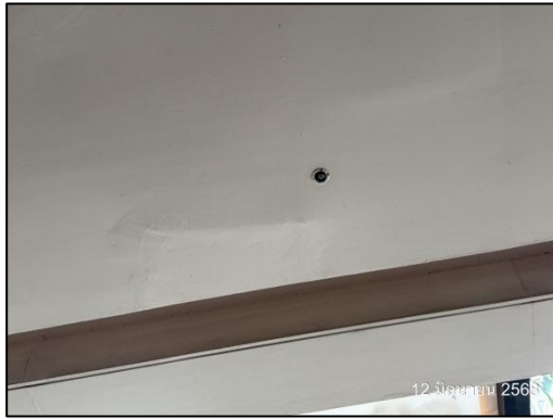
รูปที่ 51 (ต่อ) หัวกระจายน้ำดับเพลิง (Sprinkler Head)
