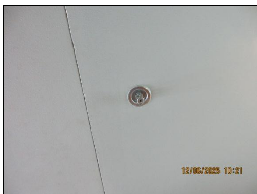
รูปที่ 51 หัวกระจายน้ำดับเพลิง (Sprinkler Head)
