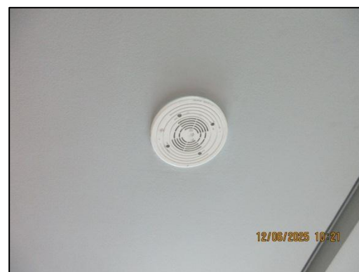
รูปที่ 57 อุปกรณ์ส่งเสียงแจ้งเหตุเพลิงไหม้
