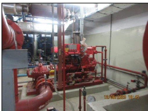
รูปที่ 48 ชุดเครื่องสูบน้ำดับเพลิง
