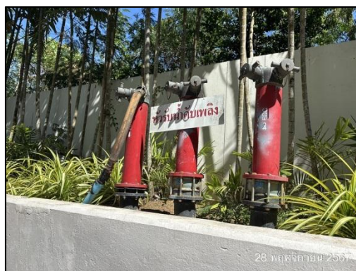
รูปที่ 49 หัวรับน้ำดับเพลิง (Fire Department Connection : FDC)
