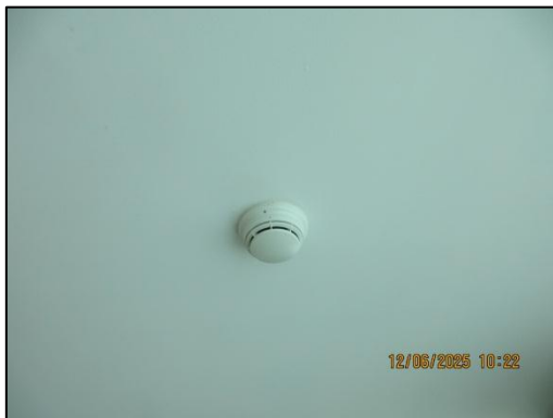
รูปที่ 58 เครื่องตรวจจับควัน (Smoke Detector)
