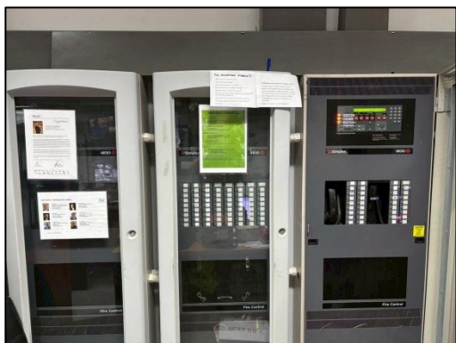
รูปที่ 55 แผงควบคุมระบบสัญญาณแจ้งเหตุเพลิงไหม้ (Fire Alarm Control Panel : FCP)
