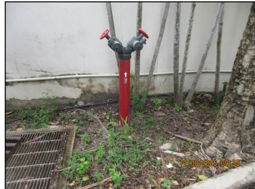
รูปที่ 50 (ต่อ) หัวจ่ายน้ำดับเพลิง
