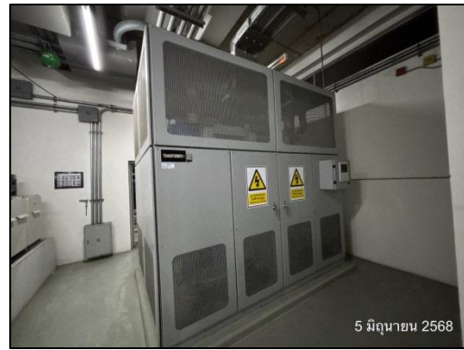
รูปที่ 47 (ต่อ) ห้องหม้อแปลงไฟฟ้าของโครงการ
