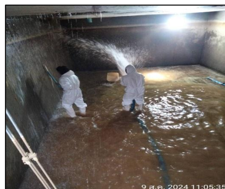
รูปที่ 46 ล้างถังเก็บน้ำของโครงการ
