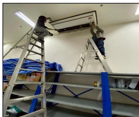
รูปที่ 11 ทำความสะอาดเครื่องปรับอากาศ
