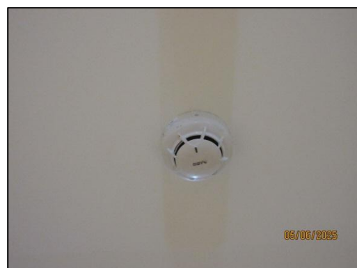
รูปที่ 73 เครื่องตรวจจับควัน
