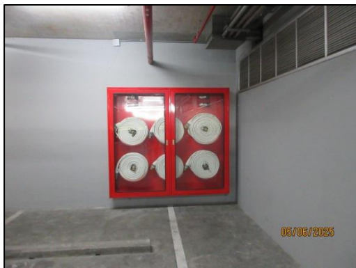
รูปที่ 71 (ต่อ) ตู้เก็บสายฉีดน้ำดับเพลิงพร้อมอุปกรณ์การใช้
