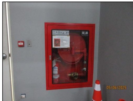
รูปที่ 71 (ต่อ) ตู้เก็บสายฉีดน้ำดับเพลิงพร้อมอุปกรณ์การใช้
