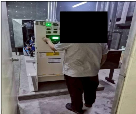
รูปที่ 15 เครื่องกำเนิดไฟฟ้าสำรอง
