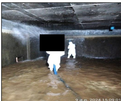
รูปที่ 46 (ต่อ) ล้างถังเก็บน้ำของโครงการ
