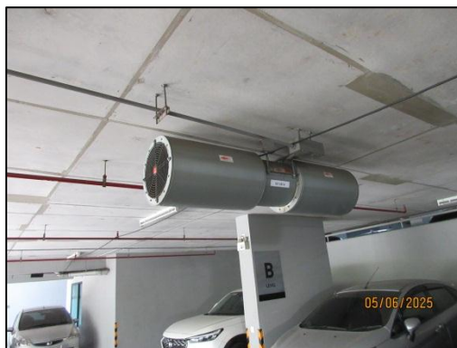
รูปที่ 9 ระบบระบายอากาศแบบพัดลมเจ็ต (Jet Fan)
