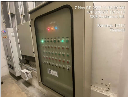
รูปที่ 9 (ต่อ) ระบบมิเตอร์ไฟฟ้าระบบบำบัดน้ำเสีย
