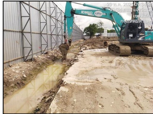
รูปที่ 35 (ต่อ) ขุดลอกทางระบายน้ำ
