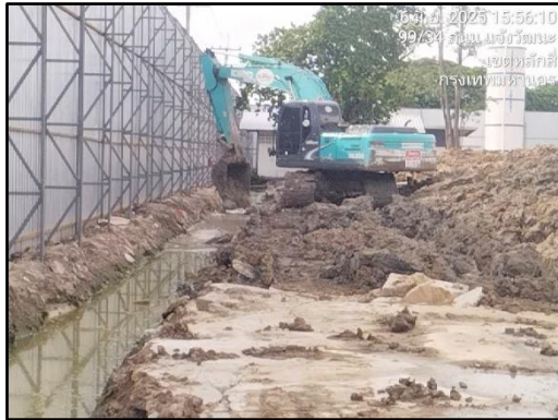
รูปที่ 35 (ต่อ) ขุดลอกทางระบายน้ำ
