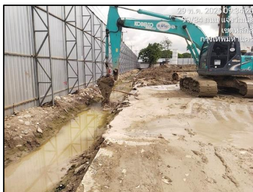
รูปที่ 35 ชุดลอกรางระบายน้ำ
