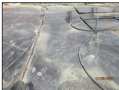
รูปที่ 36 ปูแผ่นเหล็ก (Platform)
