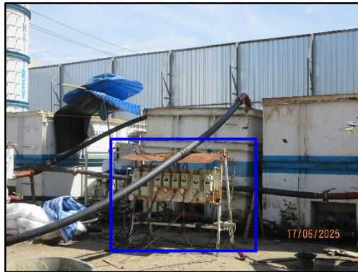
รูปที่ 57 แผงจ่ายไฟฟ้าชั่วคราว
