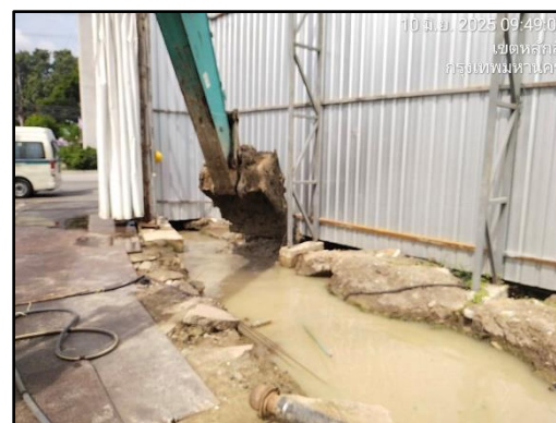
รูปที่ 35 ชุดลอกรางระบายน้ำ
