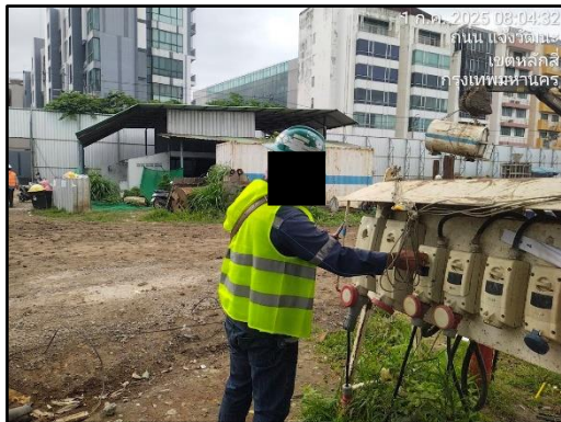
รูปที่ 57 แผงจ่ายไฟฟ้าชั่วคราว
