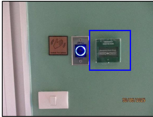
รูปที่ 69 ปุ่มกดฉุกเฉิน (Emergency Door Release)
