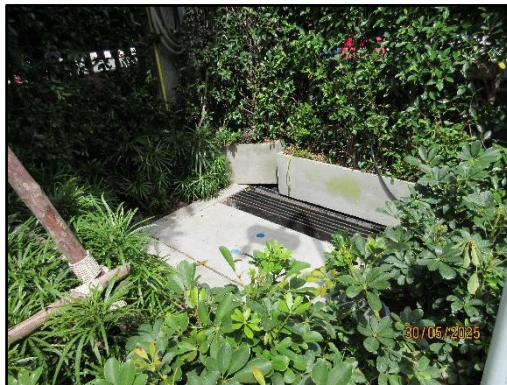
รูปที่ 42 ป่อพักน้ำก่อนปล่อยน้ำออกสู่ท่อระบายน้ำสาธารณะ
