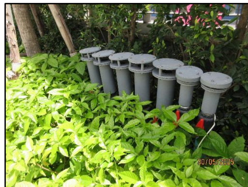
รูปที่ 25 ท่อระบายก๊าซ
