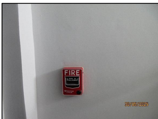
อุปกรณ์แจ้งเหตุเพลิงไหม้ด้วยมือ อาคาร B
