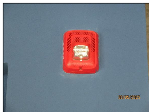
อุปกรณ์แจ้งสัญญาณเตือนด้วยเสียงและแสง อาคาร B
