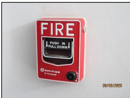
อุปกรณ์แจ้งเหตุเพลิงไหม้ด้วยมือ อาคาร A
