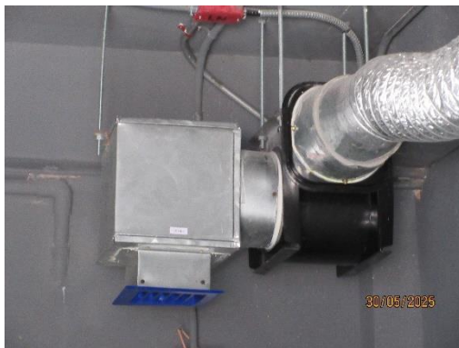
รูปที่ 52 เครื่องดูดอากาศ ภายในห้องพักรมฝอยเปียก
