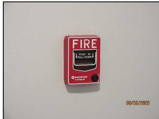
อุปกรณ์แจ้งเหตุเพลิงไหม้ด้วยมือ อาคาร A
