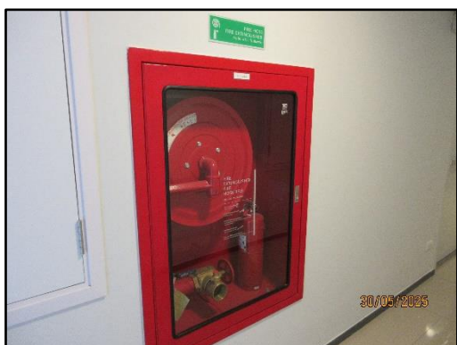
ตู้เก็บสายฉีดน้ำดับเพลิง/ถังดับเพลิง อาคาร A
