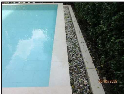
รูปที่ 29 รางระบายน้ำล้นมีฝาปิดรอบสระว่ายน้ำ
