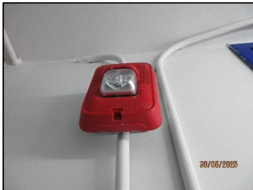
อุปกรณ์แจ้งสัญญาณเตือนด้วยเสียงและแสง อาคาร A
