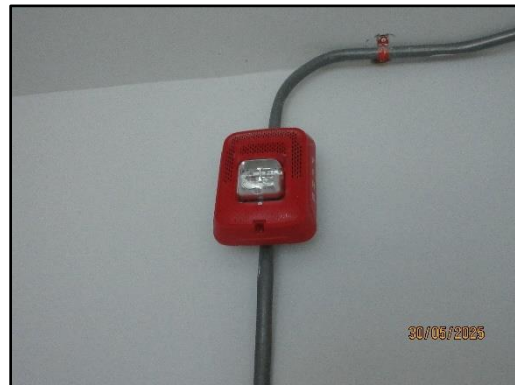
อุปกรณ์แจ้งสัญญาณเตือนด้วยเสียงและแสง อาคาร A
