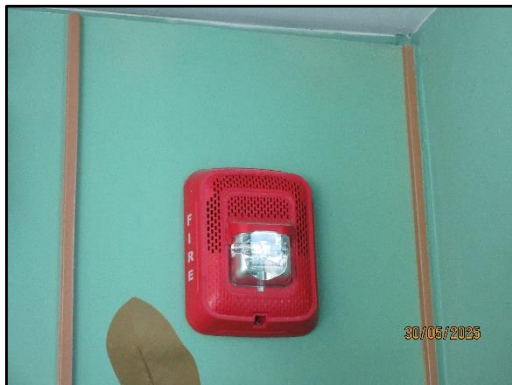
อุปกรณ์แจ้งสัญญาณเตือนด้วยเสียงและแสง อาคาร A
