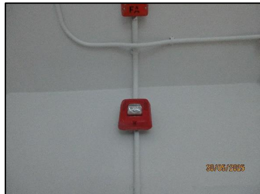
อุปกรณ์แจ้งสัญญาณเตือนด้วยเสียงและแสง อาคาร A
