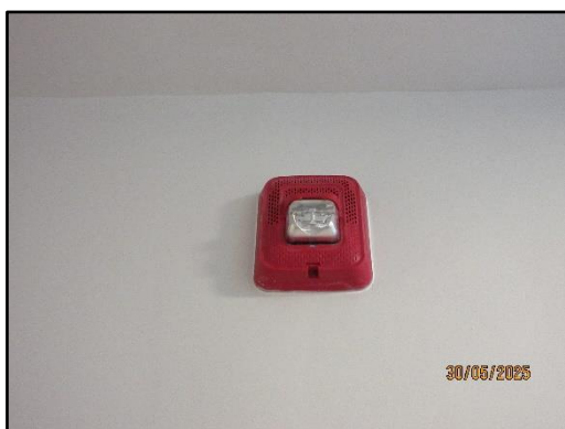
อุปกรณ์แจ้งสัญญาณเตือนด้วยเสียงและแสง อาคาร B
