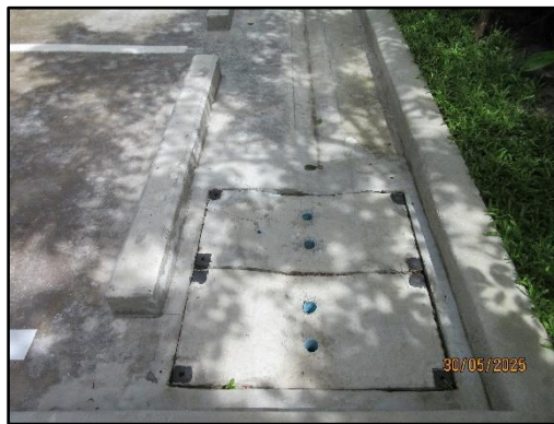
รูปที่ 44 ท่อระบายน้ำและร่องระบายน้ำ
