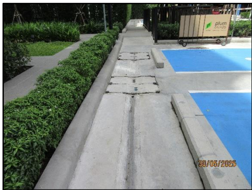
รูปที่ 44 ท่อระบายน้ำและร่องระบายน้ำ
