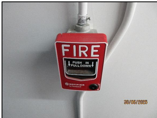
อุปกรณ์แจ้งเหตุเพลิงไหม้ด้วยมือ อาคาร A
