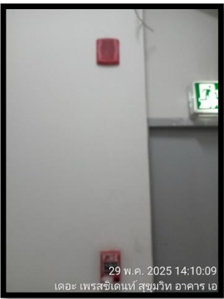
เครื่องแจ้งเหตุและกริ่งสัญญาณ
