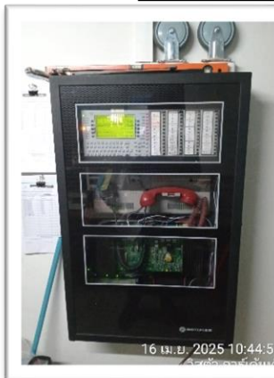
แผงควบคุม Fire Alarm
