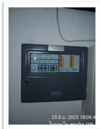
แผงควบคุม Fire Alarm
