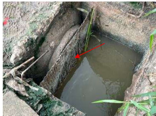
รูปที่ 35 ตะแกรงดักขยะ
