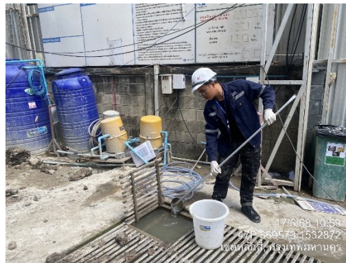
บ่อกักน้ำชั่วคราว ก่อนระบายออกจากพื้นที่ก่อสร้างลงสู่ท่อระบายน้ำสาธารณะ บริเวณด้านหน้าโครงการ
