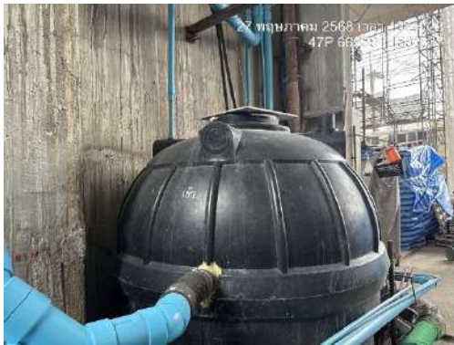
รูปที่ 21 ถังระบบบำบัดสำเร็จรูป
